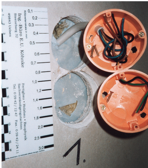
Abb. 3: Einbau der Elektroninstallationsdosen.
