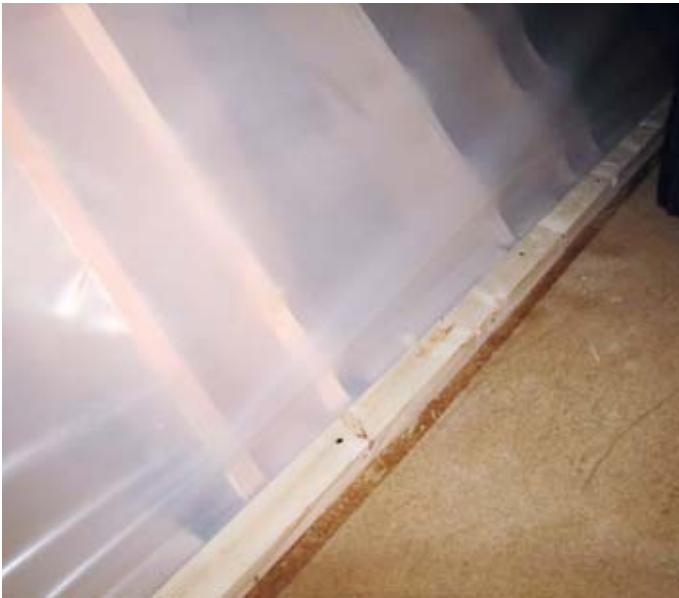
Abb. 2: Auf den 1. Blick ist die Folie als luftdichte Ebene perfekt verarbeitet.
