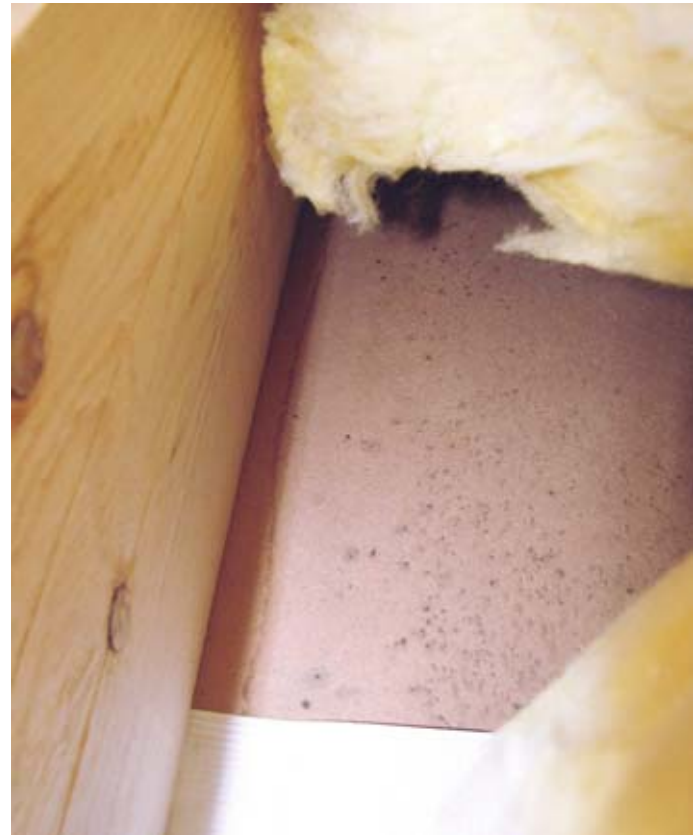
Abb. 1: Kondensat an der Weichfaserdämmplatte auf dem Dach durch Warmlufteintrag aus der Geschossdecke.
