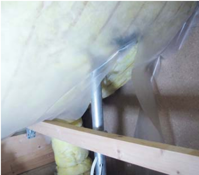
Abb. 4: Übles Fehlstellen der luftdichten Ebene nach Antenneneinbau.
