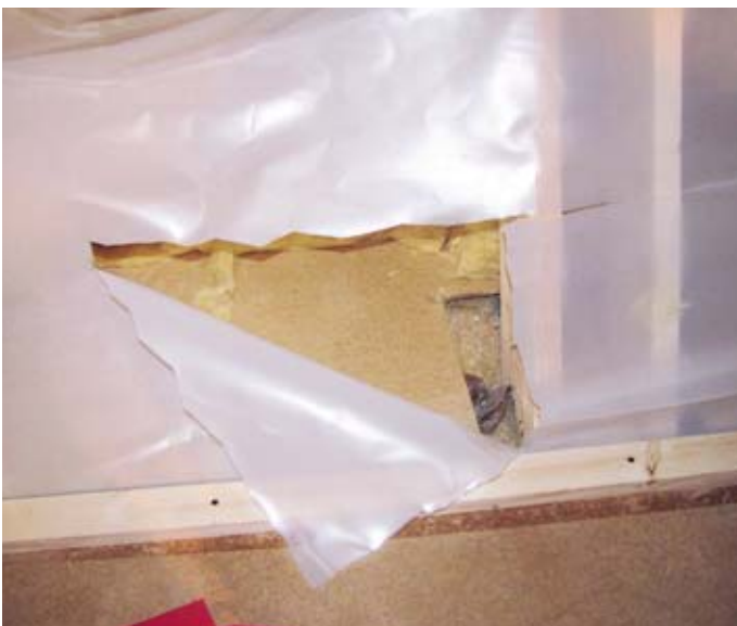
Abb. 3: Aber die Ausschnitte im Bereich der Laschen ließen warme Luft aus der Decke hinter der luftdichten Ebene einströmen.
