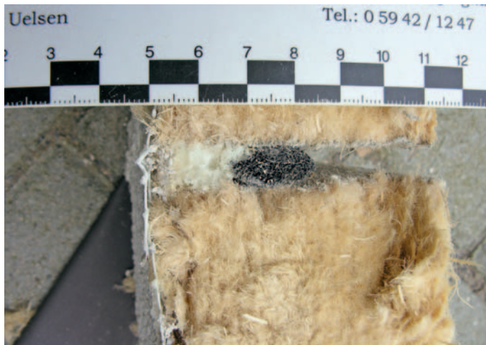
Abb. 3: Bei den relativ harten Weichfaserplatten hat sich hier die ges. Verformung auf die ungenügend und nicht drucksteife Stoßfuge konzentriert, wodurch auch hier Putz samt Gewebe „ausbeult.“
