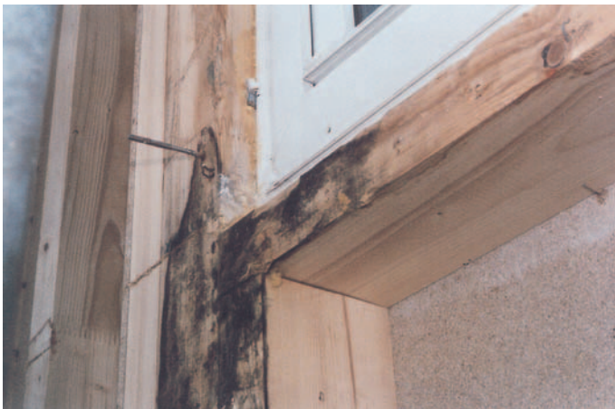
Abb. 7: Schaden an einem großen Bürogebäude. Nach dem Abnehmen des WDVS ist der Feuchteintritt sichtbar, nicht nur am Fensterbankbordstück, sogar an der Stockschraube!
