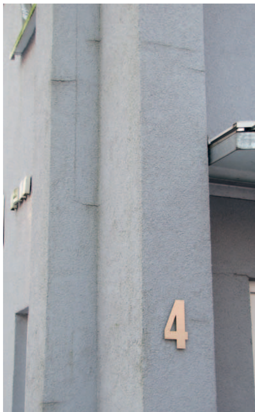
Abb. 4: Extreme Schäden im Stoßbereich der Profile.
