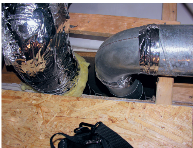
Abb. 4: Die Rohrschächte sich in der Kehlbalckendecke nicht verschlossen – in diesem Fall auch nicht erforderlich
