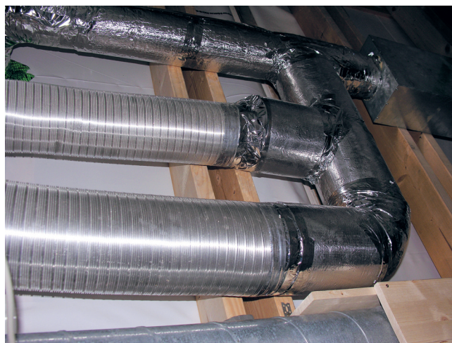
Abb. 2: Die Rohre der Lüftungsanlage liegen auf der Kehlbalkendecke im beheizten Volumen.
