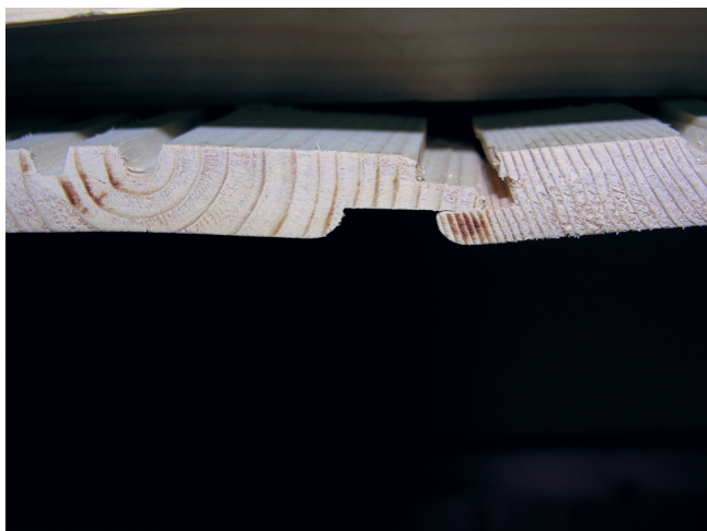
Abb. 3: Die starken Verformungen der rückseitig nicht behandelten Profilbretter
