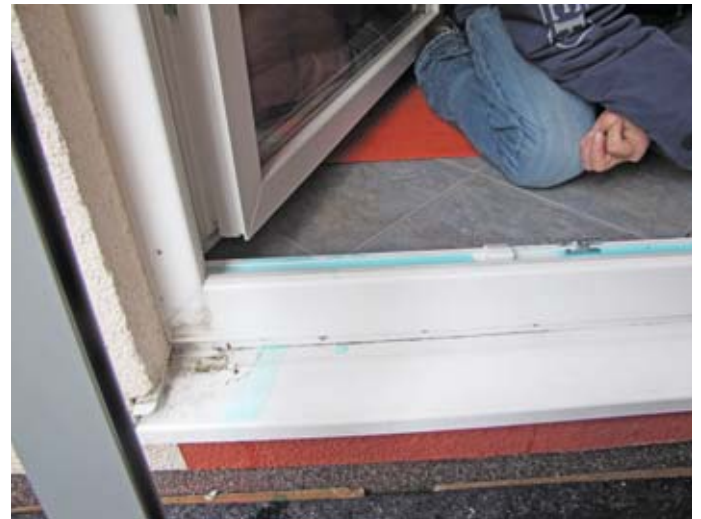
Abb. 3: In den Entwässerungsbereich des Blendrahmens wird blau gefärbtes Wasser eingegeben, welches an der Unterseite des Blendrahmens austritt.
