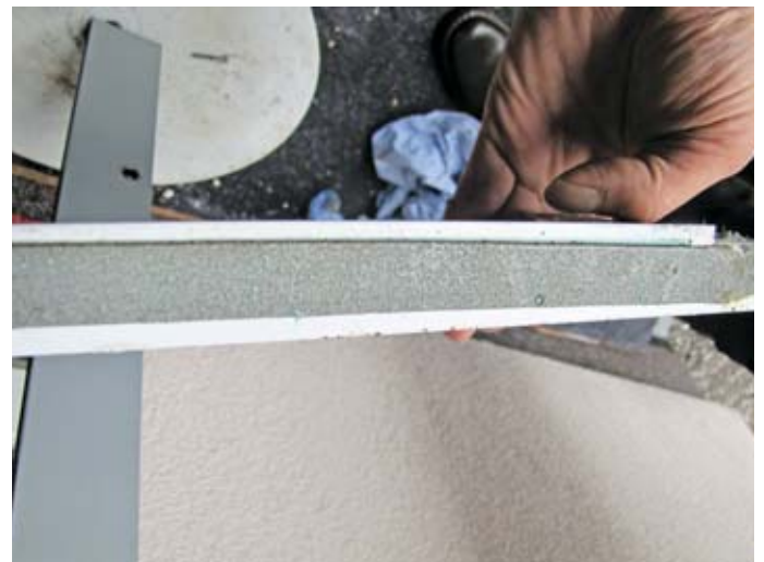
Abb. 5: Rückansicht der hinteren Bankaufkantung. Durch das Dichtungsband bildet sich im Bereich Oberseite Bankaufkantung eine Rinne, in welche das Wasser bei starkem Wind eingetrieben wird.
