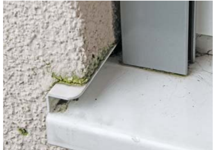
Abb. 1: Fensterbankecke – der Abriss zwischen Fensterbankbordstück und Putz führt zu Feuchteaufnahme und Moosansatz im Putz.
