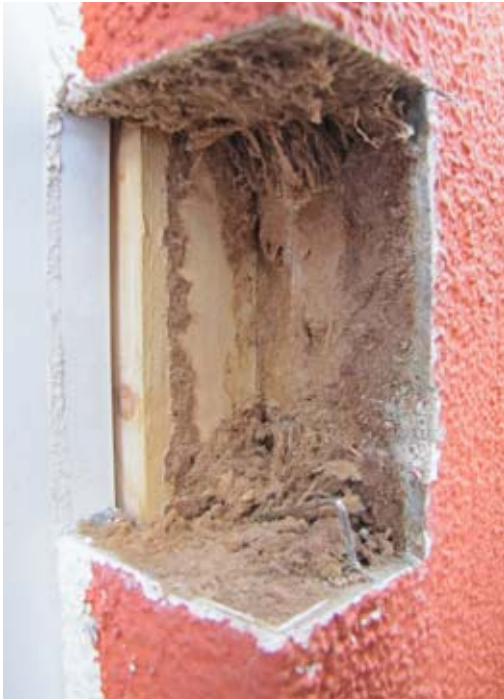
Abb. 6: Obwohl die Anschlussfuge nicht fachgerecht vollgedämmt und abgedichtet ausgeführt wurde, lag absolut kein Hinweis auf Kondensatbildung vor.
