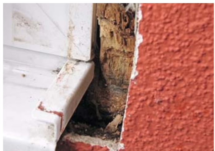
Abb. 2: Im Endbereich der Fensterbank ist die Holzkonstruktion bereits stark geschädigt.
