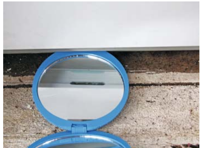
Abb. 4: Im Spiegel erkennbar, die nach unten im Bereich der Fensterbankaufkantung angeordnete Entwässerungsöffnung.
