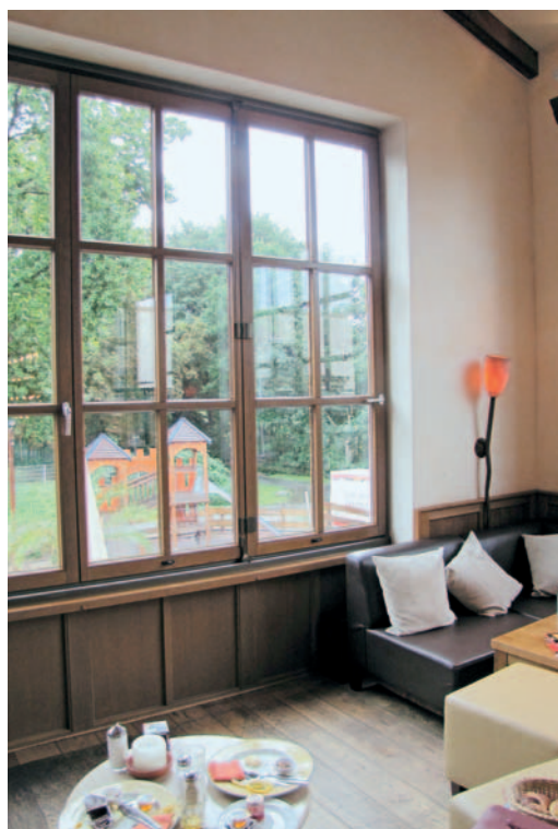
Abb. 4: Zeigt Fensterschiebeelement Obergeschoss.
