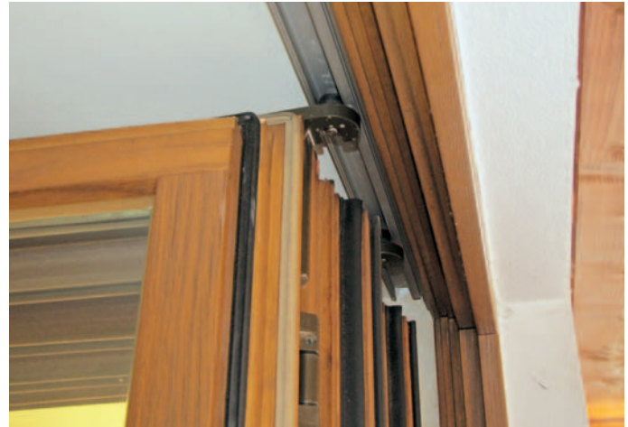
Abb. 1: Zeigt das geöffnete falt-/Schiebeelement im Bereich der oberen Führung.
