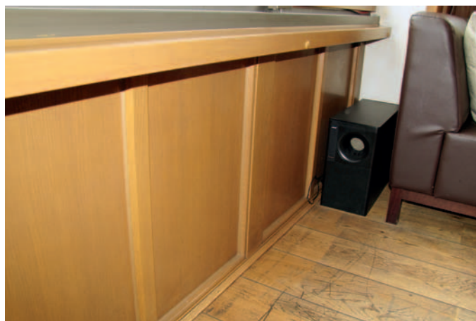
Abb. 5: Zeigt Brüstung unter dem Faltschiebeelement im 1. Obergeschoss. Hier wäre eine Kastenträgerkonstruktion sinnvoll.
