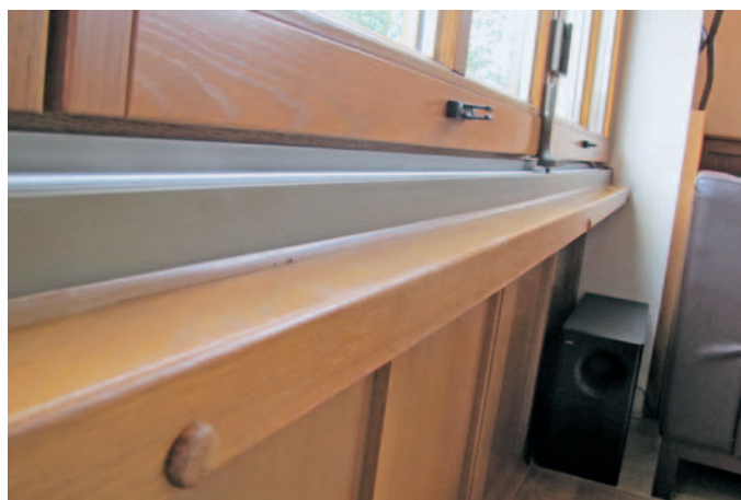
Abb. 6: Detailansicht Übergang zwischen unterem und oberem Element der Faltschiebeanlage im Obergeschoss.
