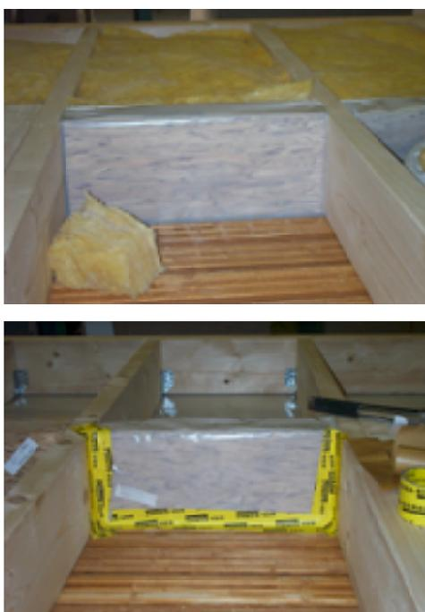
Bild 41: Abdichtung der der auskragenden Geschossdecke mit Folie im Gebäude 3\*.
