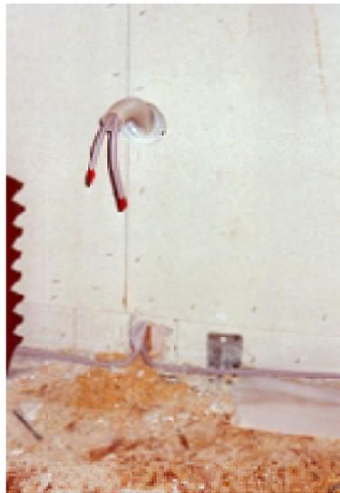
Bild 37: Andichtung eines Leerrohres mit Silikon.
