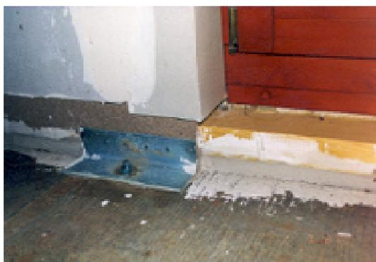
Bild 10: Untermörtelung als luftdichten Abschluss der Schwelle.
