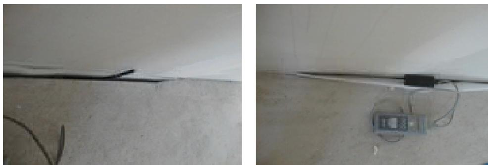
Bild 48: Der Estrich ist nicht bis an die Außenwand gegossen (ca. 2,1 m/s).
