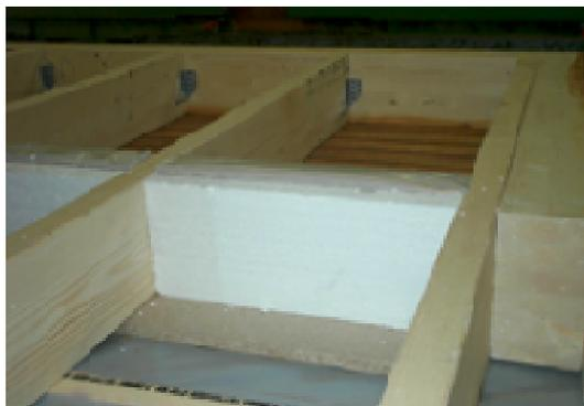
Bild 9: Die Trittschalldämmplatte wird mit Übermaß geschnitten und eingefügt. Durch die Deckelplatte wird die Oberseite abgedichtet. Auf die Sparren kann zusätzlich ein kurzes Stück Dichtband gelegt werden.
