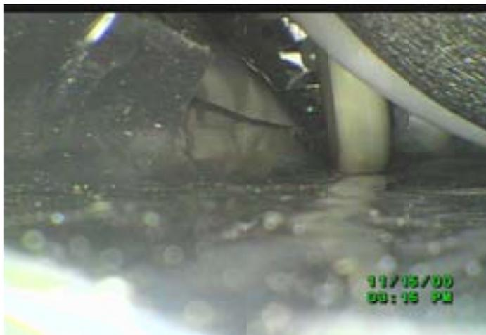
Bild 15: Ein zusätzlicher Klebestreifen verhindert die Leckage im Anschlußbereich Fußboden / Außenwand bzw. bodentiefe Türen.
