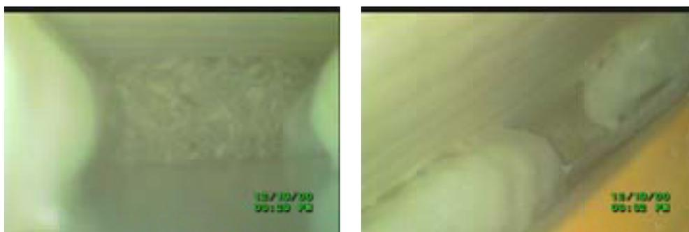
Bild 51: Ansichten eines Hohlraumes zwischen Gipswinkel einer Balkontürleibung und der Außenwand. Das linke Bild zeigt einen Blick auf den Rolladenkasten, das rechte einen auf die Abdichtung mit Montageschaum zwischen Fenster und Außenwand.
