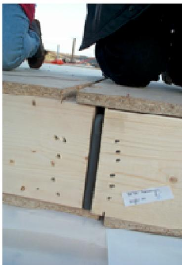
Bild 44: Schaumstoff-Hohlprofil im Deckenelementstoß nach der Montage (Gebäude 4)\*.
