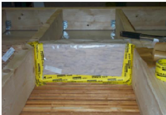
Bild 8: Abdichtung der auskragenden Geschoßdecke durch Folie und Klebenband. Die Abdichtung der Oberkante zur Deckenplatte erfolgt mit vorkomprimiertem Dichtungsband.
