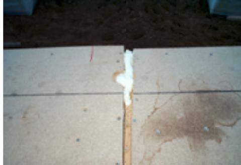
Bild 45: 'Fehlstelle' im Deckenelementstoß nach der Montage, Blick auf den Ausschnitt von Bild 44 von oben\*.
