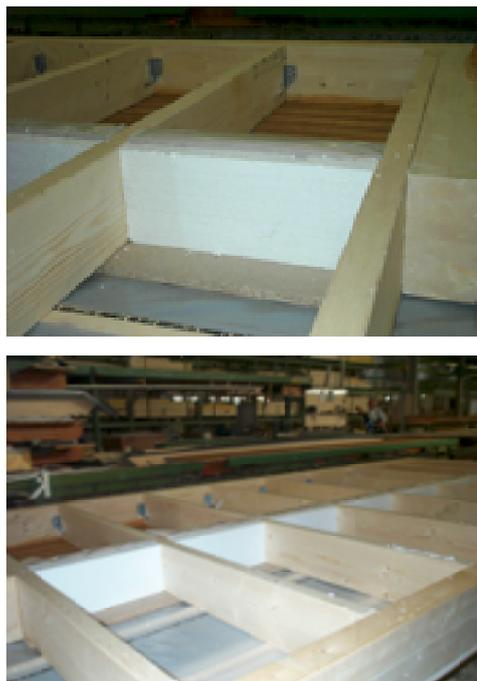
Bild 42: Trittschalldämmung als luftdichter Gefachabschluss der Geschossdecke\*.
