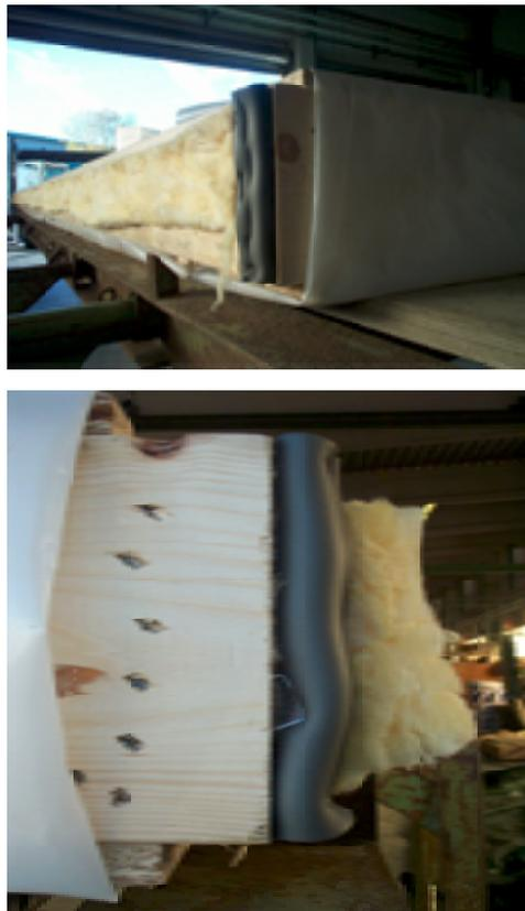
Bild 43: Vormontage der Abdichtung der Elementstöße der Geschossdecke mit Schaumstoff-Hohlprofil für Gebäude 4\*.
