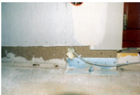
Bild 47: Durchdringung der Außenwand für eine elektrische Leitung. Die Abdichtung mit Montageschaum ist nicht luftdicht.
