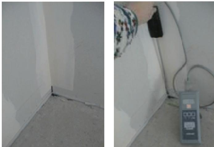
Bild 49: Die Stöße der Gipskartonplatten sind nur bis in den Fußleistenbereich geputzt (ca. 3,5 m/s).
