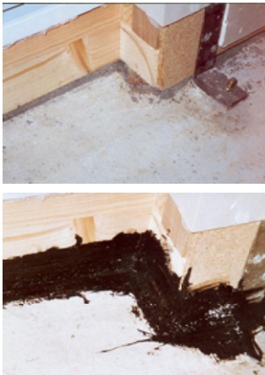
Bild 18: Abdichtung Fußboden / bodentiefe Türe mit Dichtanstrich.
