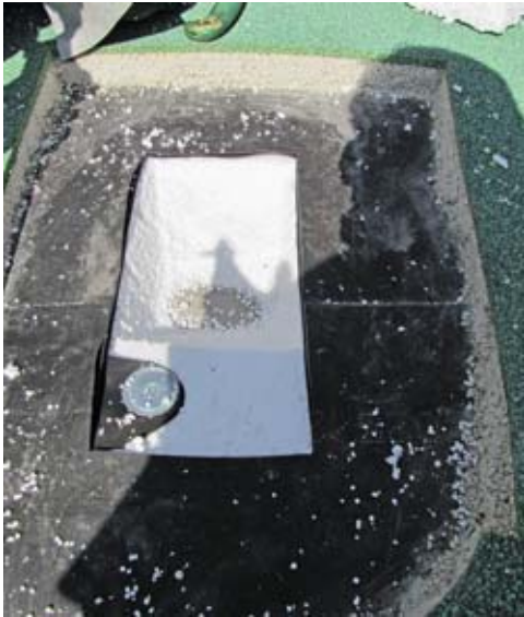
Abb. 4: Zeigt geöffnete Dachhaut mit darunter befindlicher Gefälledämmung und zementgebundener Spanplatte – ohne Feuchteinwirkungen oder irgendwelcher Beeinträchtigungen.
