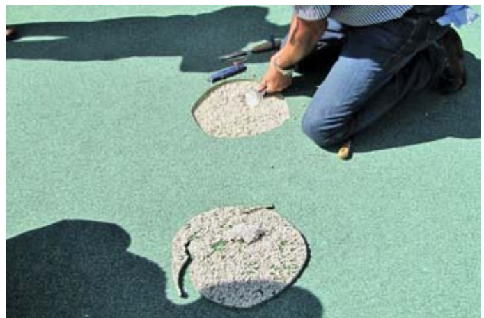
Abb. 3: Zeigt Vornahme der Bauteilöffnung.
