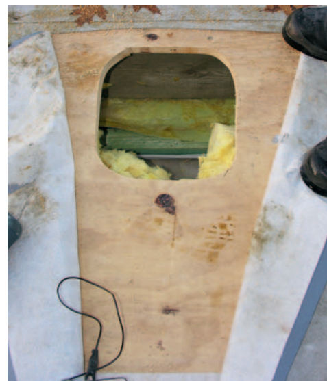
Abb. 4: Völlig intakte und trockene Konstruktion in den „besonnten Bereichen“ der Dachfläche.
