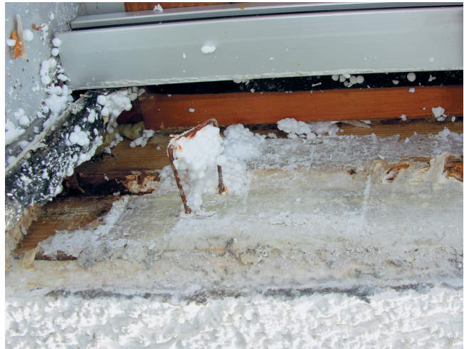
Undichtiges Fensterbank-Bordstück und die Folgen
