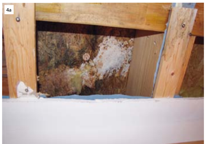
Abb. 4a und 4b: Nur allzu häufig werden Leckagen in Bädern im Dachgeschoss durch die dichte Folie zu spät erkannt.
