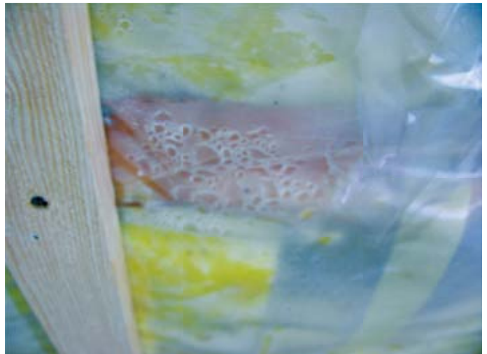
Abb. 1: Kondensat auf der Oberseite der unteren Folie der Geschosstrenndecke.
