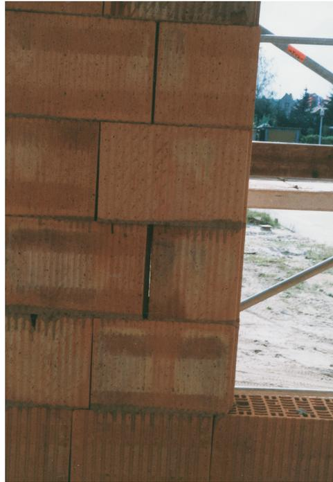
Abb. 2: Wo bitte ist hier die luftdicht verklebte Folie?
