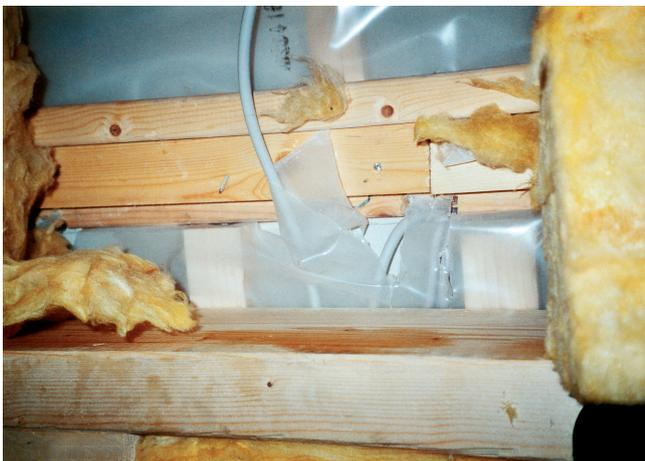
Abb. 4: Folienverklebung in der Praxis – was ist hier luftdicht?
