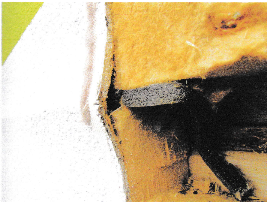
Insbesondere relativ drucksteife Holzweichfaserdämmplatten als WDVS müssen eine ebenso drucksteife Fugenverfüllung aufweisen, damit Stauchungen und Quetschfalten verhindert werden.
