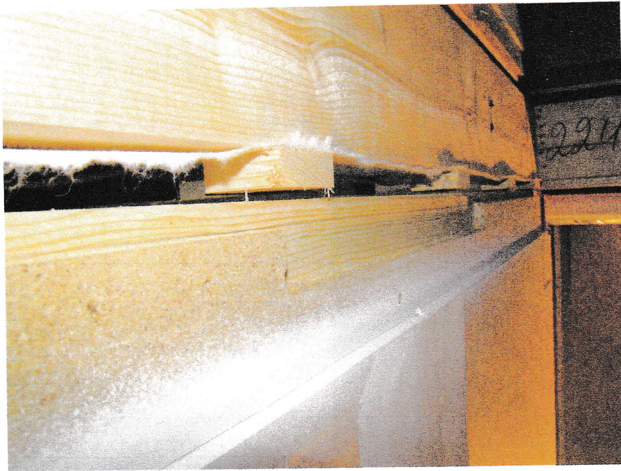
Auch das gibt es: Eine ungenügende Auflagerung der Decke am Geschosstoß führt unweigerlich zu vertikalen Bewegungen im Deckeneinbindebereich, die sich bis zum Außenputz auswirken.
